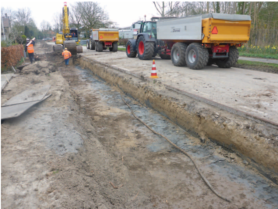
Afb. 2.02 Overzicht van de ontgraving in werkput 2.
